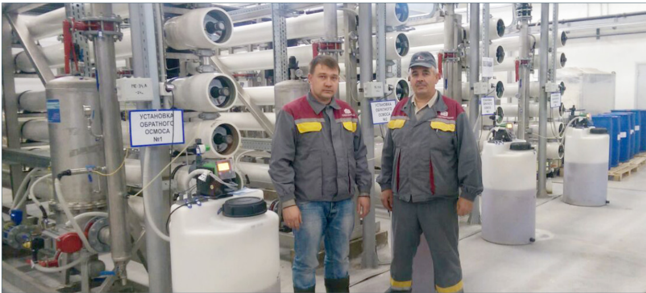
На фото: Максим Морозов - мастер котельной, Михаил Бажанов - оператор котельной
